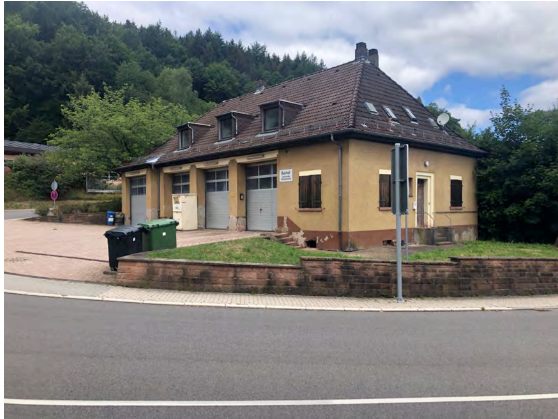
Mängel in der Bausubstanz – Autohalle
