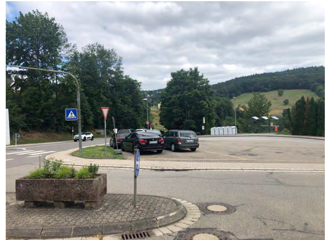
Gestaltungsmangel öffentlicher Raum – Busbahnhof, Parkplatz
